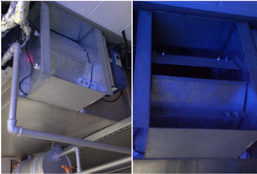
Figura 3.17 – Acionamento do Damper
