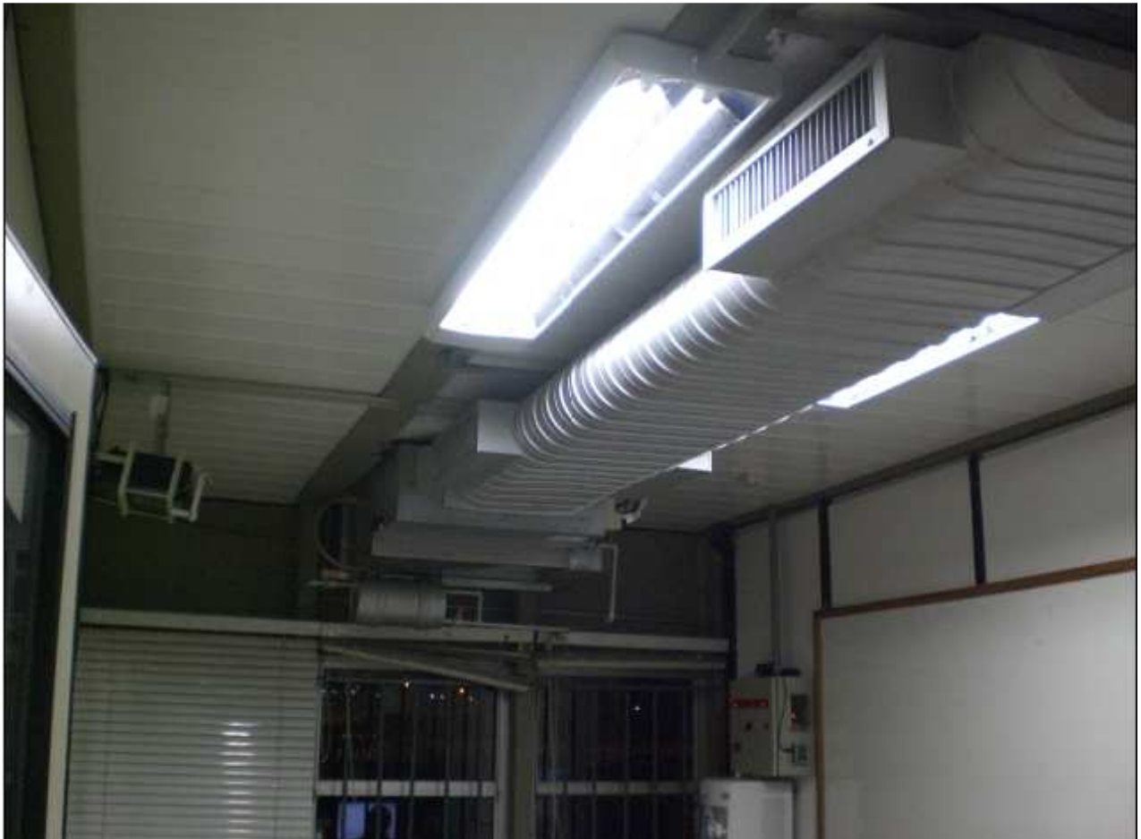
Figura 3.1 – Ar Condicionado Híbrido do LAVSI
