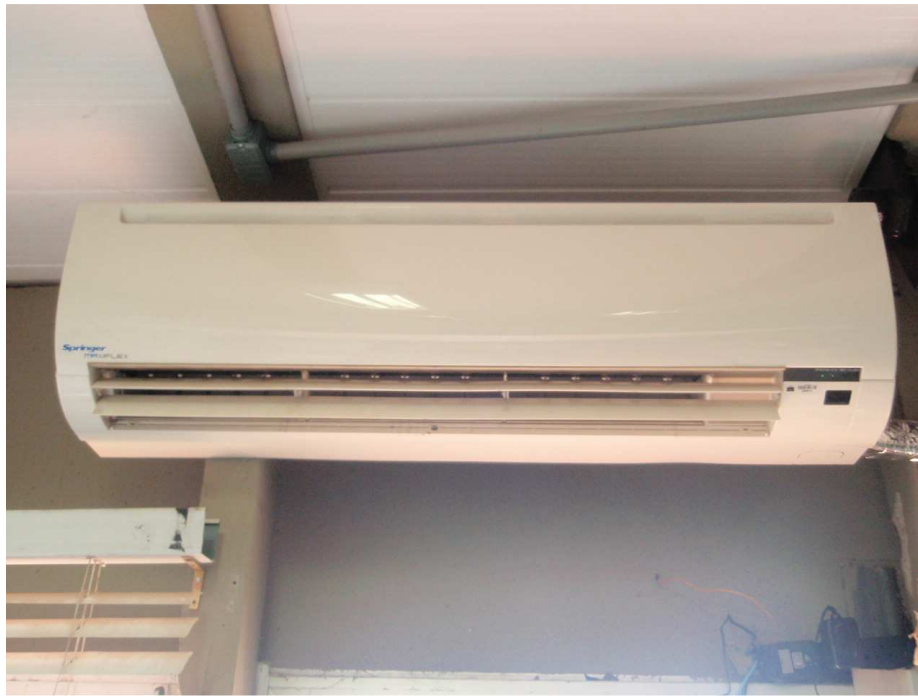
Figura 3.4: Ar condicionado Split
