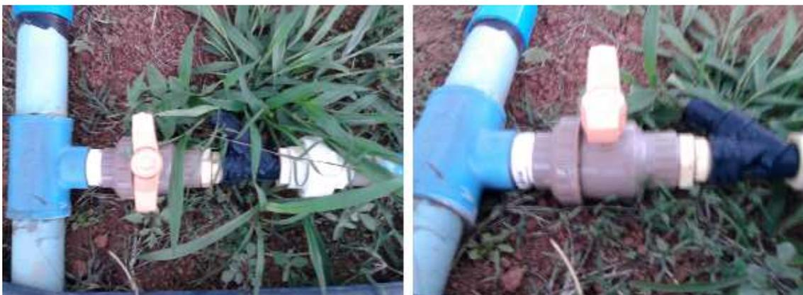
Figura 2.3. Registros utilizados em sistemas de irrigação convencional.
