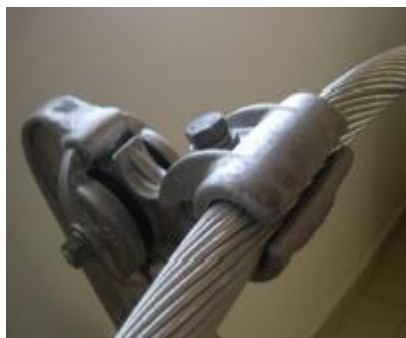
Figura 1.3: Garra presa corretamente.
