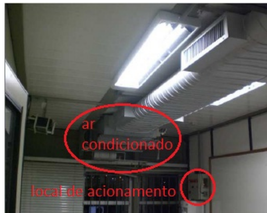
Figura 3.18: Ar condicionado híbrido utilizado no projeto.
