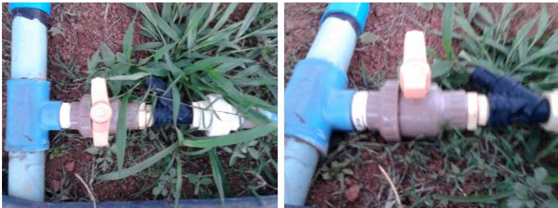
Figura 2.3. Registros utilizados em sistemas de irrigação convencionais.
