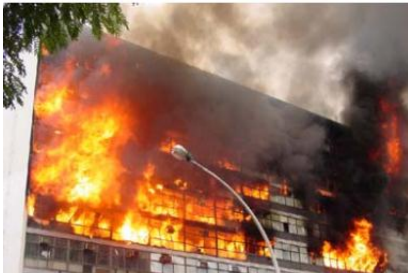
Figura 2.3. Fenômeno de generalização do incêndio. Fonte: Carvalho et al (2009).
