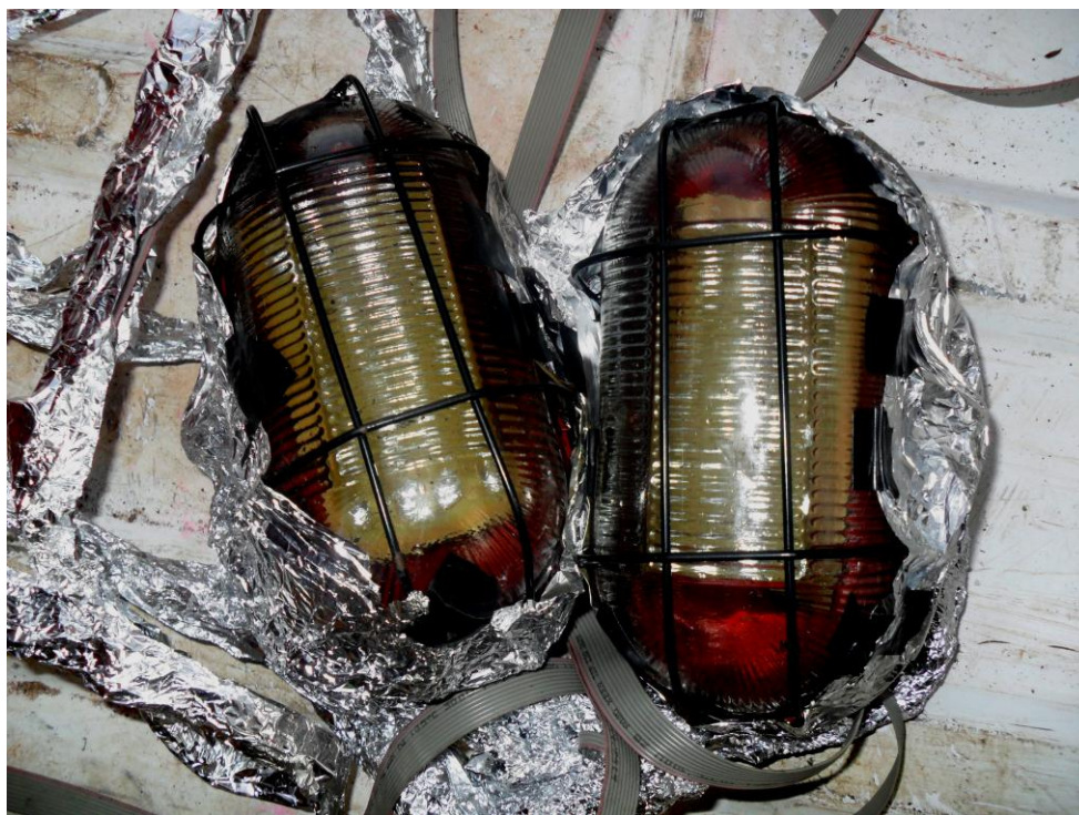
Figura 5.13. Condições dos painéis após a realização de um dos experimentos.
