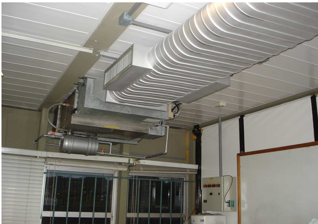
Figura 4.1 - Sistema híbrido de climatização da sala de reunião do LAVSI
