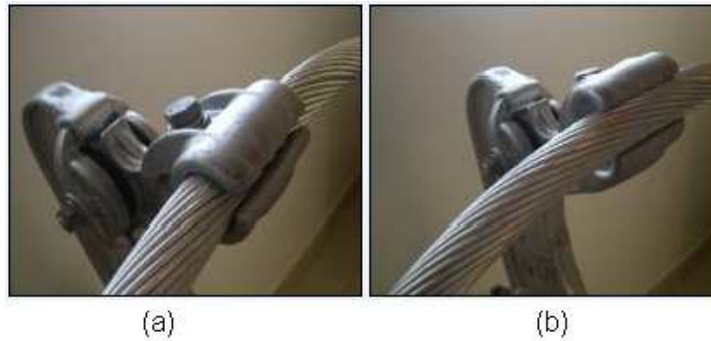
Figura 1.5: Ilustração da garra de um separador: (a) Bem ajustada (ok). (b) Solta (nok).
