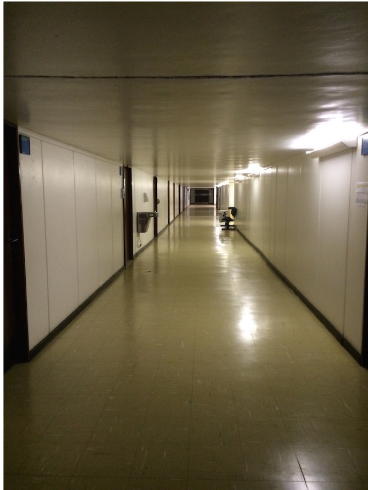
Figura I.2: Área superior do prédio SG11 utilizada para a realização dos experimentos
