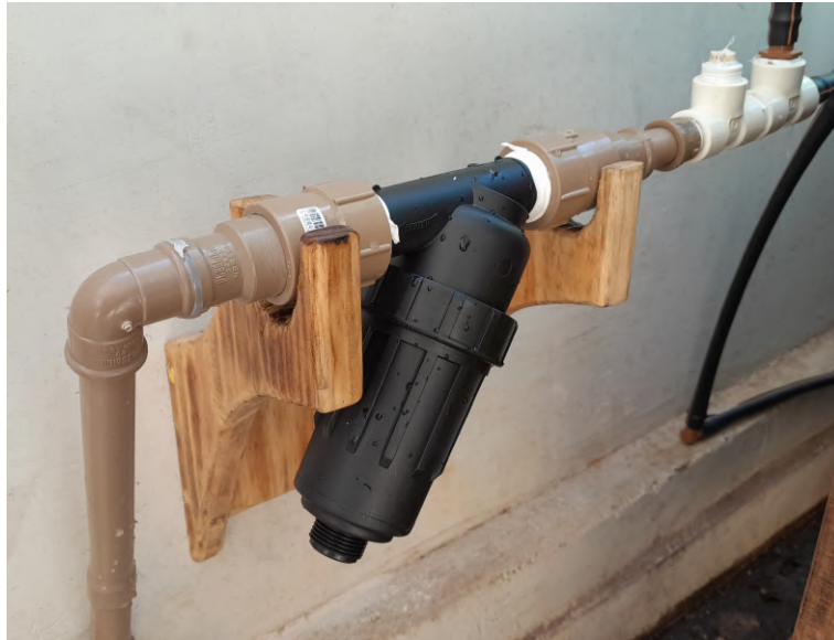
Figura 4.62 – Filtro Plástico Tela 1" Tavlit - Netafim
