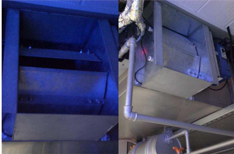
Figura 3.3 Foto do *dumper* do sistema de refrigeração. À esquerda com a entrada semi-aberta e a direita fechada.
