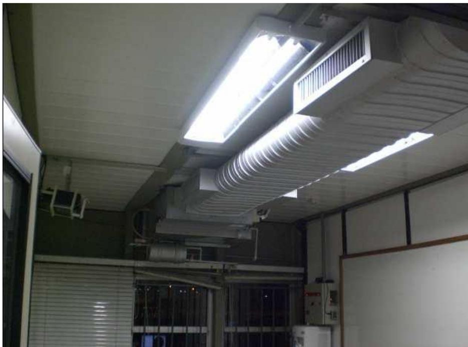
Figura 3.1 - Foto do sistema híbrido de climatização instalado na sala do GRAV na Universidade de Brasília
