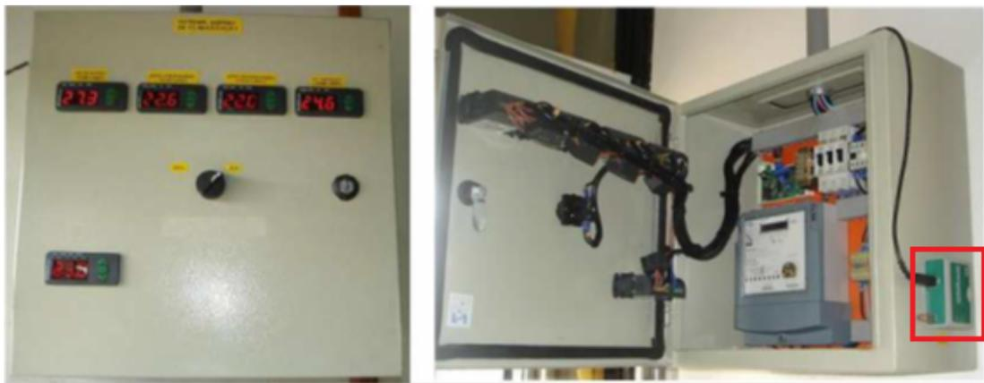
Figura 3.9 Painel elétrico de Controle e Interface de comunicação serial CONV 32.
