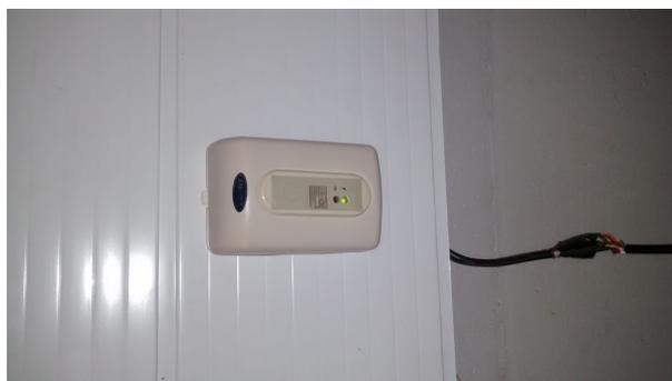
Figura 3.12: Controle remoto com fio.
