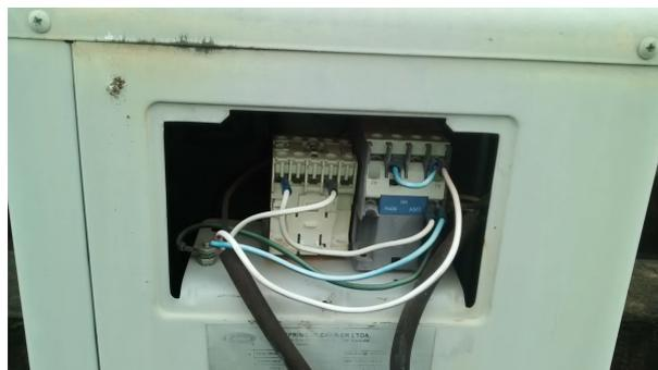
Figura 3.14: Terminais da condensadora.
