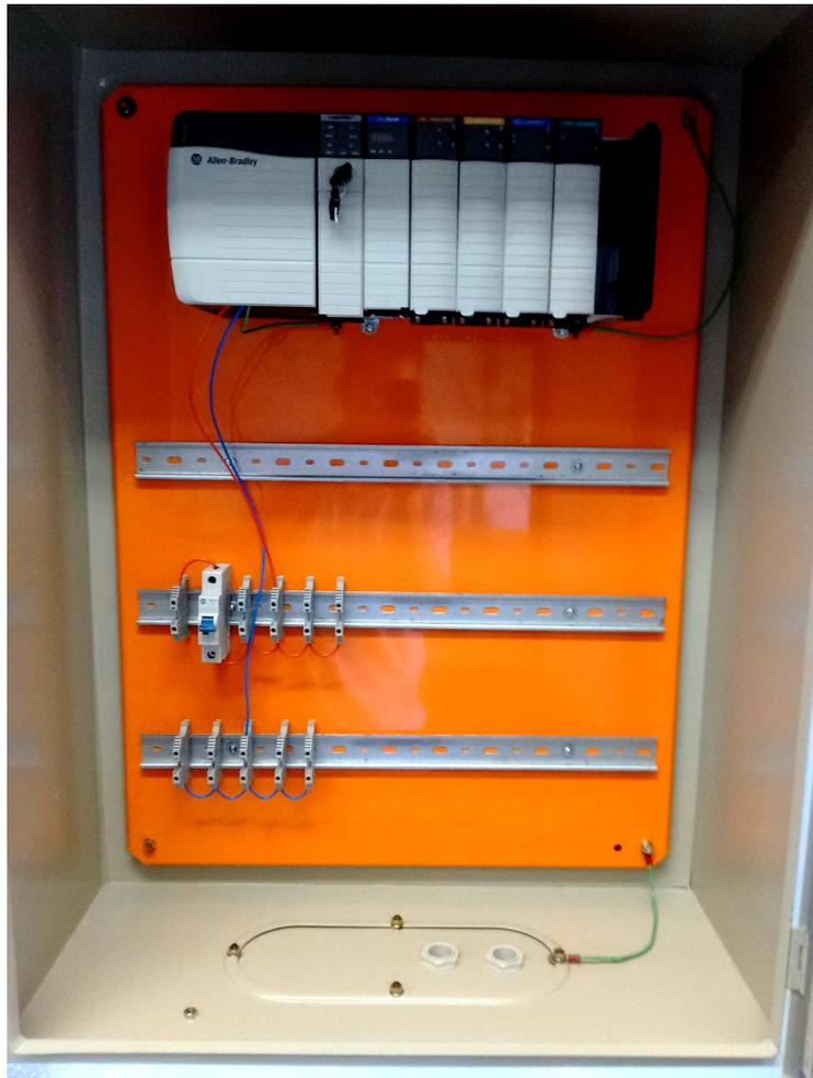
Figura 2.4: CLP no painel elétrico
