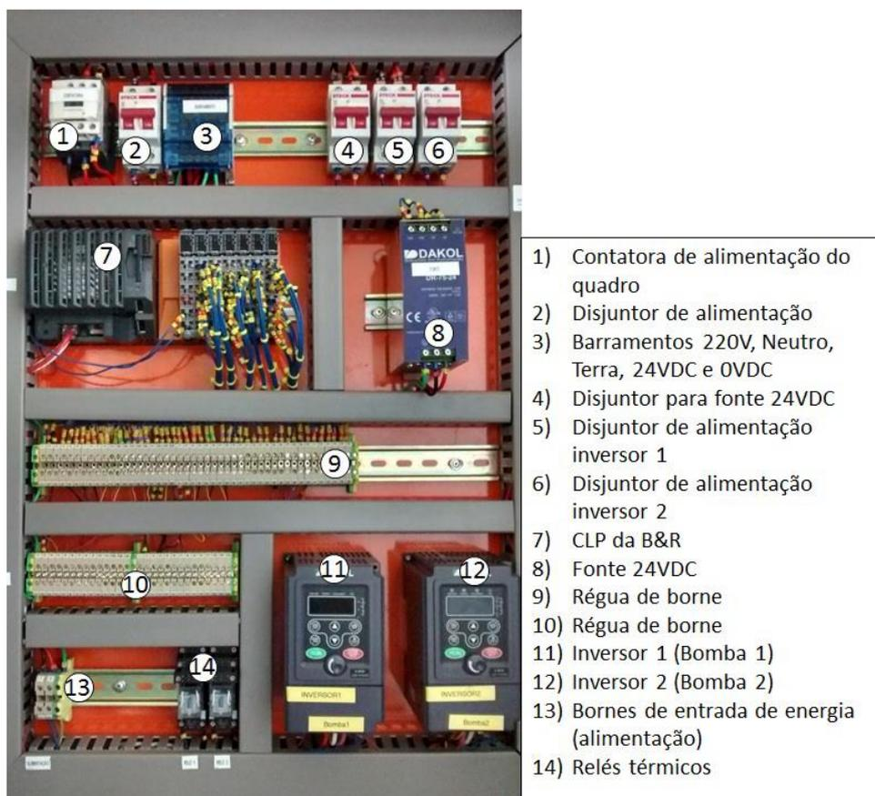
Figura 3.1 - Foto do quadro elétrico
